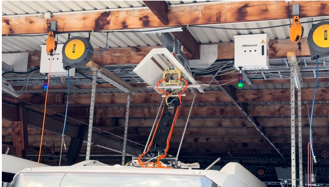
Ladung im Depot mit Ladehaube und Pantograph-Up oder mit CCS-Stecker
